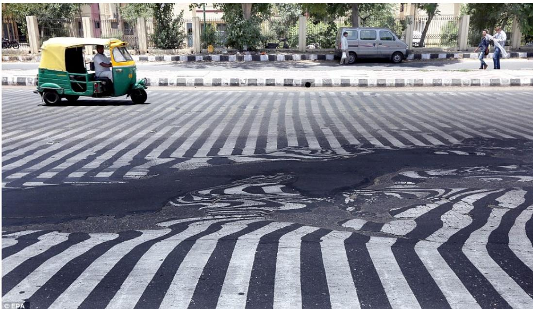
Figure 1: Déformations suite à la fonte partielle de la chaussée à Dehli en Inde en 2015. Source : The Guardian.
