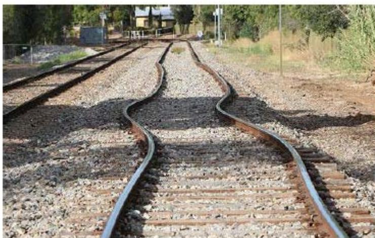
Figure 2: Déformation de rails lors de la canicule de 2003 sur la ligne de RER D
